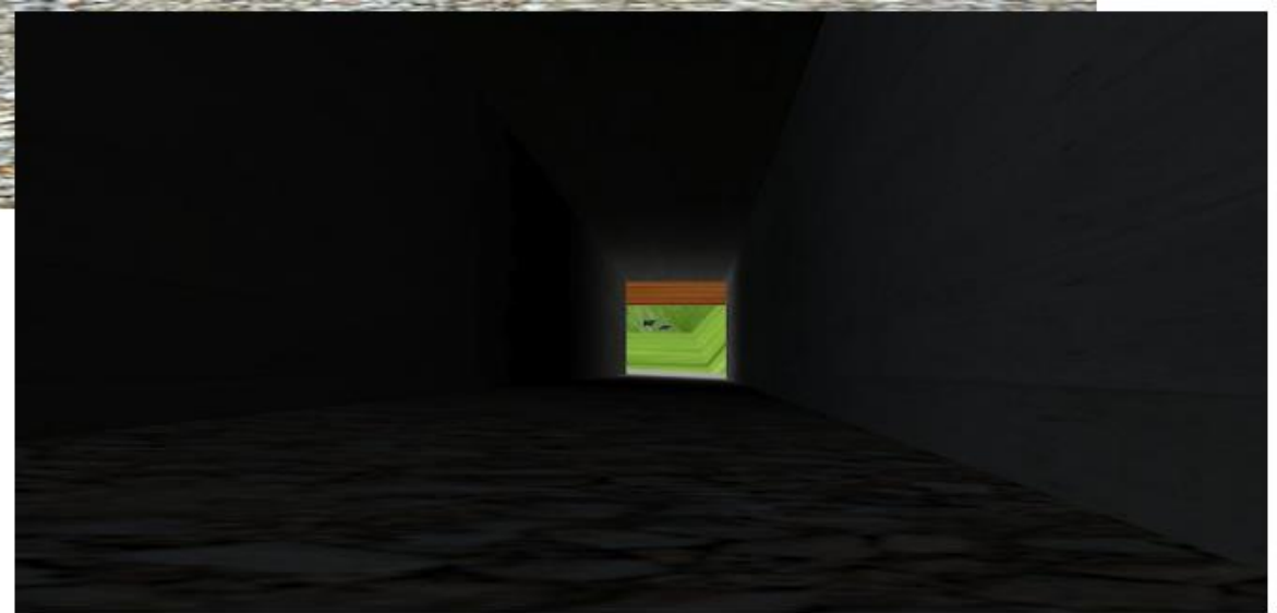
POHLED Z TUNELOVÉHO ZÁKRYTU
