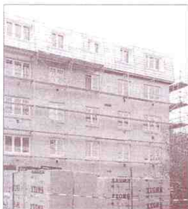
nástavby na bytovky
